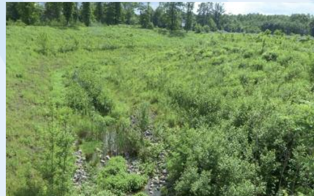
Beispiel für eine ökologische Verbesserung: der Springbach
