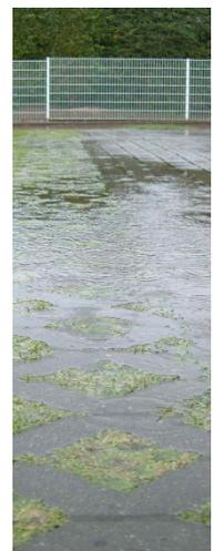
Die als wasserdurchlässig angebotenen Befestigungsarten sind jedoch nicht als dauerhaft wasserdurchlässig anzusehen. Dies gilt insbesondere auch im Hinblick darauf, dass unter bestimmten Witterungsbedingungen eine Sättigung der zunächst durchlässigen Befestigungsart eintreten kann und bei darauffolgenden Starkregen eine Wasseraufnahme nicht mehr oder nur erheblich eingeschränkt stattfindet.
